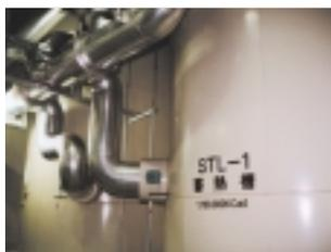
初台本社の蓄熱式空調設備は、夜間の電力でつくった冷水を利用し、昼間の電力使用量を抑制します。
